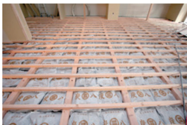
床下に敷き詰められた炭八
